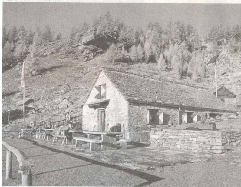
Lavori di ampliamento per la capanna Alzasca del CAS Locarno.
